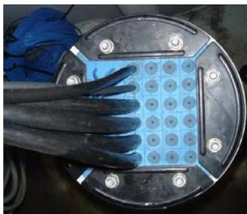
Les passages de cloison qui permettent d'isoler 2 zones et évitent la transmission des vibrations.
