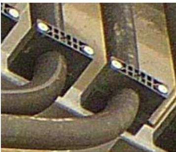
On distingue ici les supports de canalisation qui permettront de soutenir le poids de la canalisation afin d'éviter des efforts sur les raccords, et les vibrations. Il faudra veiller à les positionner afin de permettre la variation de longueur des canalisations dues aux dilatations thermique et / ou barométrique.
